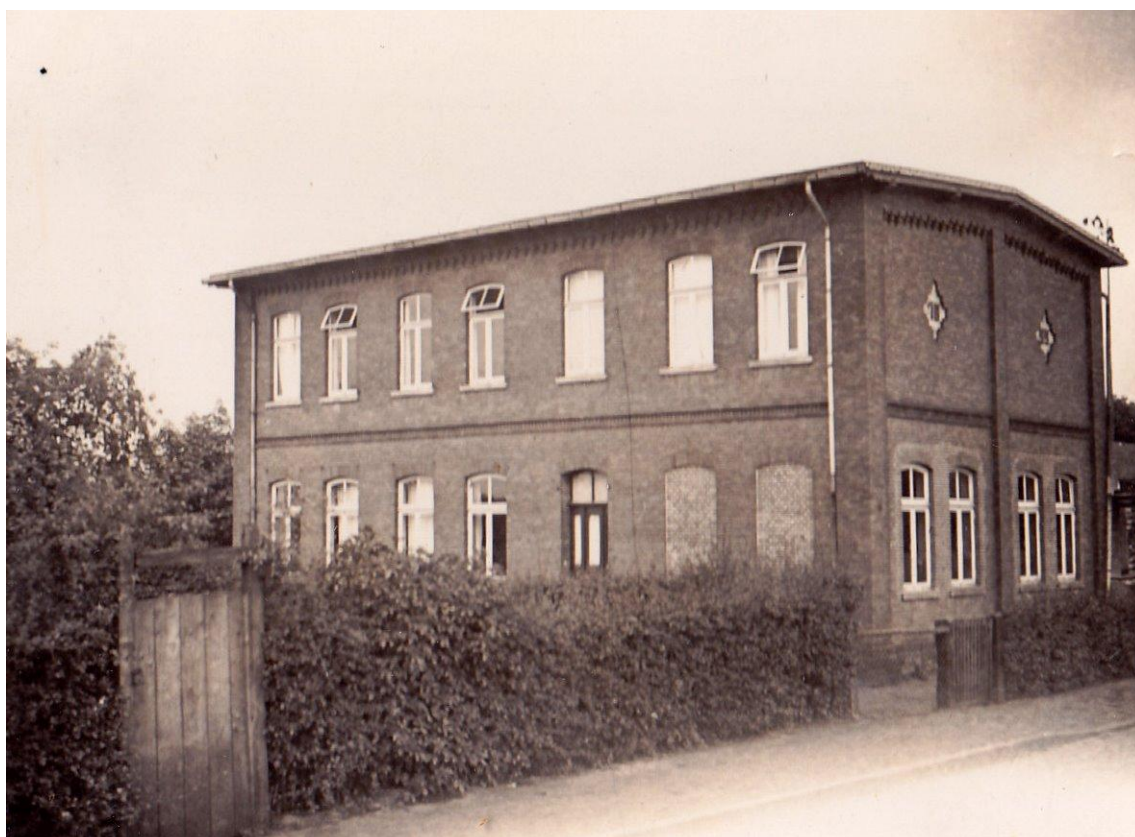
Das Schulgebäude der Höheren Töchterschule in der Hafensstraße. Foto aus der Schulchronik. (Foto: Stadtarchiv Lingen)
