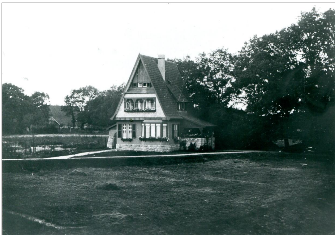
„Haus Emshagen“ am westlichen Emsufer in Schepsdorf (Foto: Heimatverein Schepsdorf)
